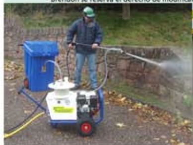
Limpieza chorro arena
